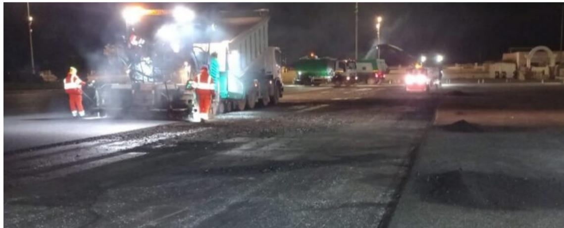
**L**ungo le carreggiate centrali della Colombo, tra il cavalcavia di via Cilicia e l'intersezione con la Laurentina, sono in corso i lavori a cura di Anas per completare gli interventi di manutenzione della strada sia con il rifacimento della pavimentazione e della segnaletica orizzontale sia con lo sfalcio, la pulizia delle banchine e la messa in quota di chiusini e caditoie. I lavori sono in programma sino al prossimo 10 agosto: intervento di rinnovo della pavimentazione stradale si
